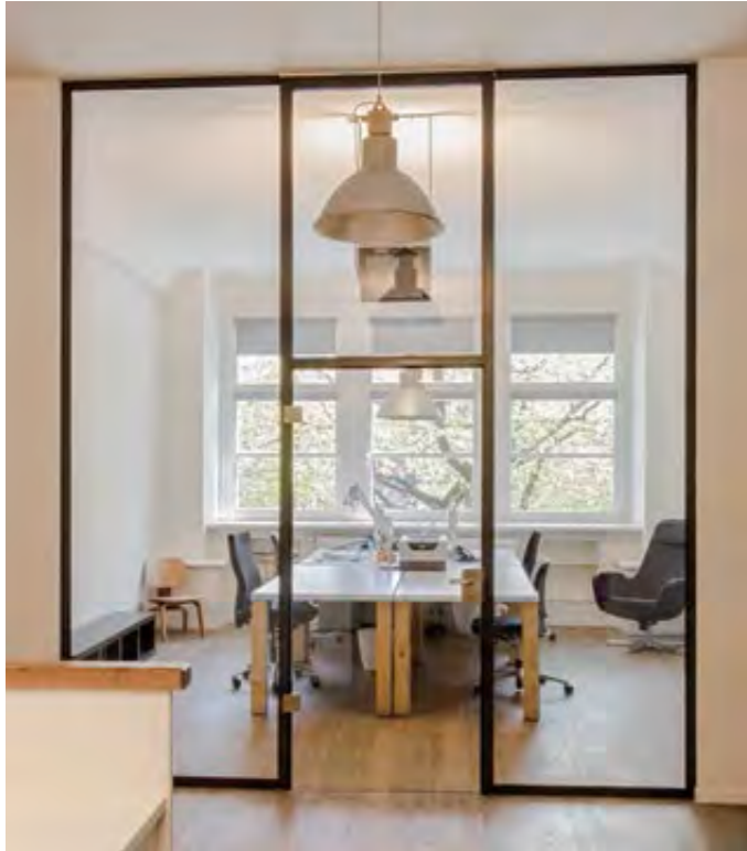
Glastrennwand – dank Zargentür auch akustisch wirksam
