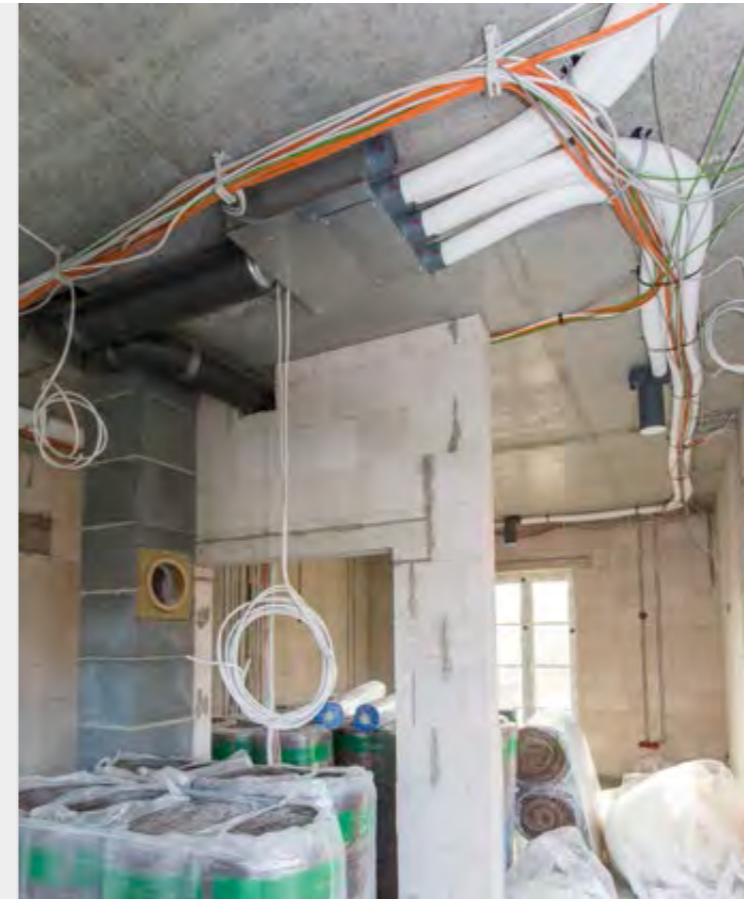
Bauphase: noch sichtbare Lüftungs- und Elektrotechnik
