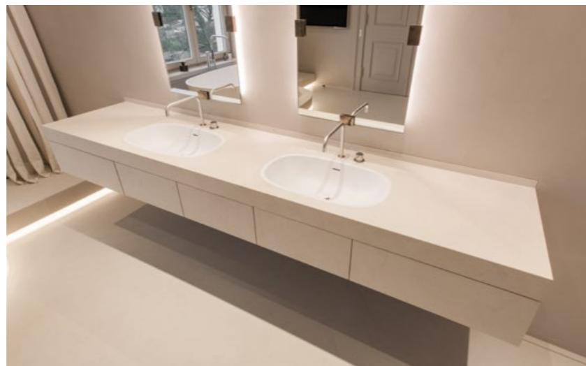
Die gespachtelten Flächen wurden farblich auf die Möbelemente abgestimmt
