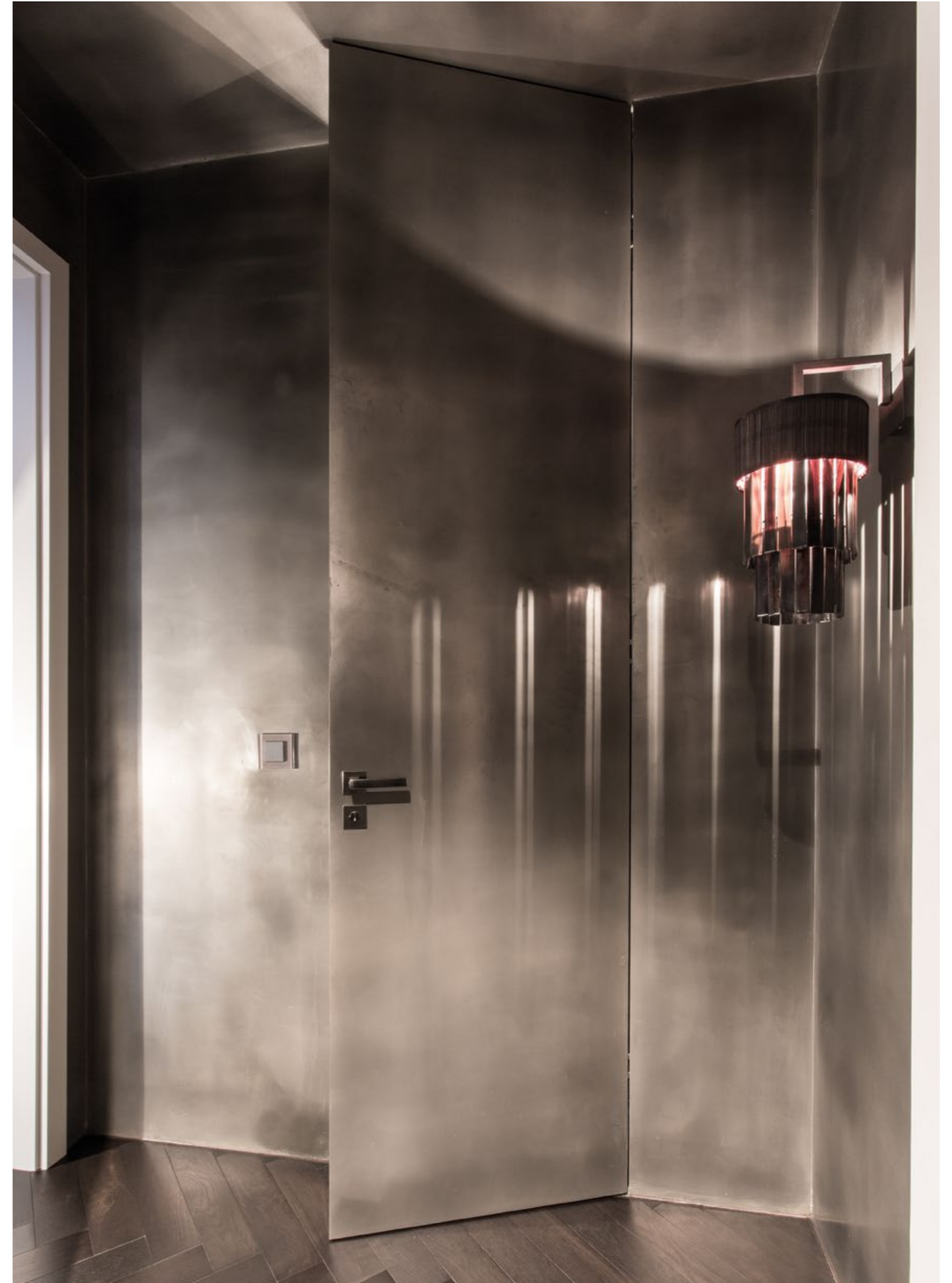
Spachteltechnik metal X in Platin
