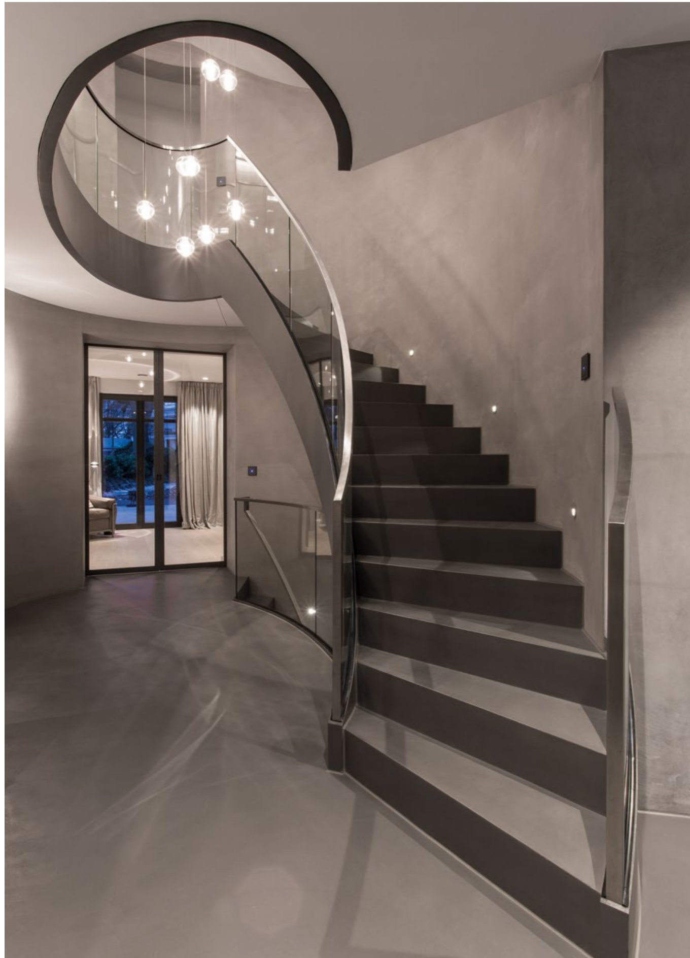
Spachteltechnik in wand09 beton an den elliptischen Wänden
