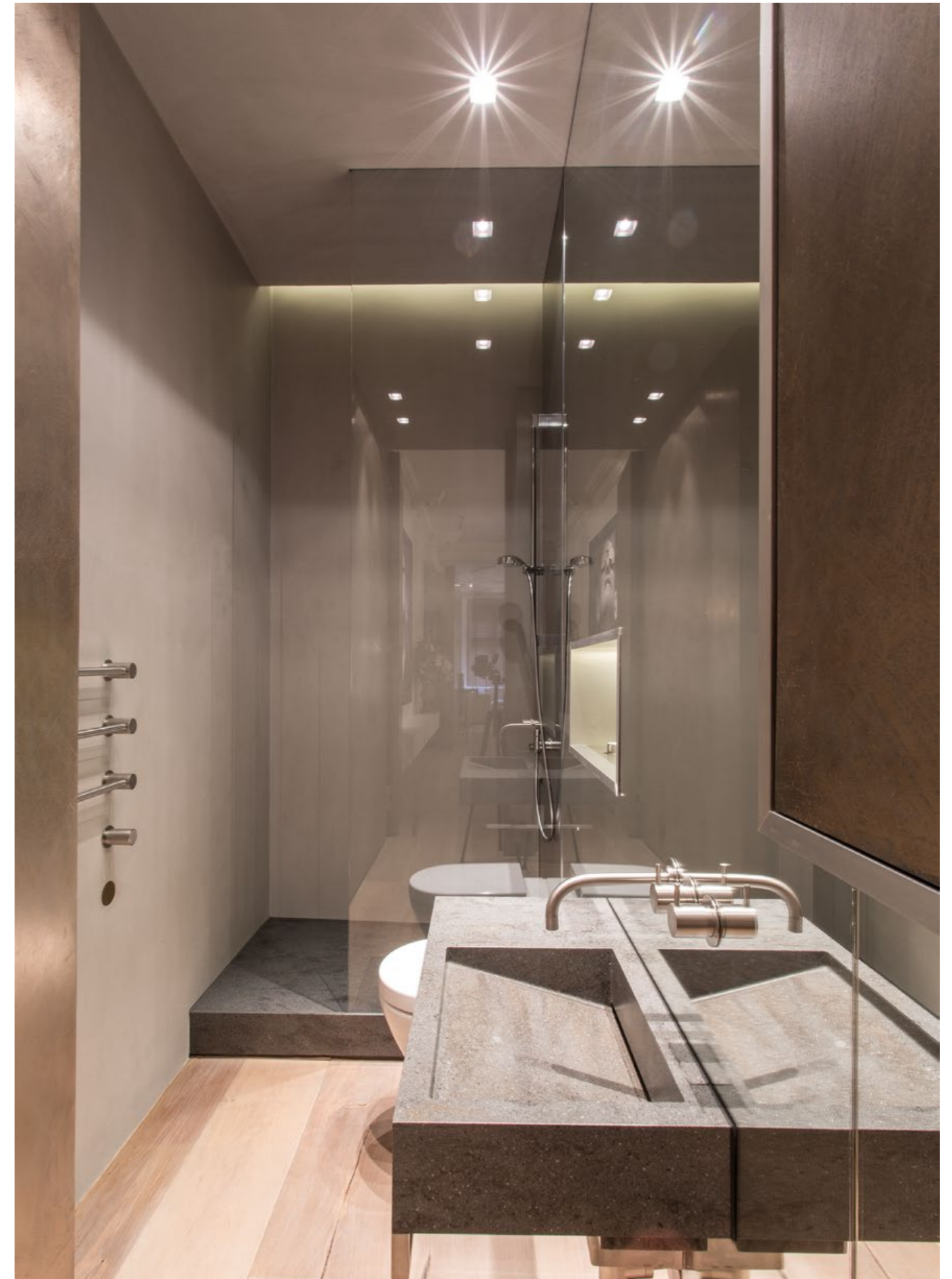
Die Wände im Duschbereich des Gästebades sind ebenfalls in fusion betongrau gespachtelt
