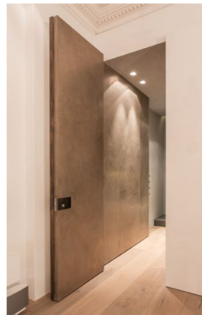
Gästebad mit flächenbündig eingelassenem Türblatt, Oberfläche in metal X, brünierte Bronze
