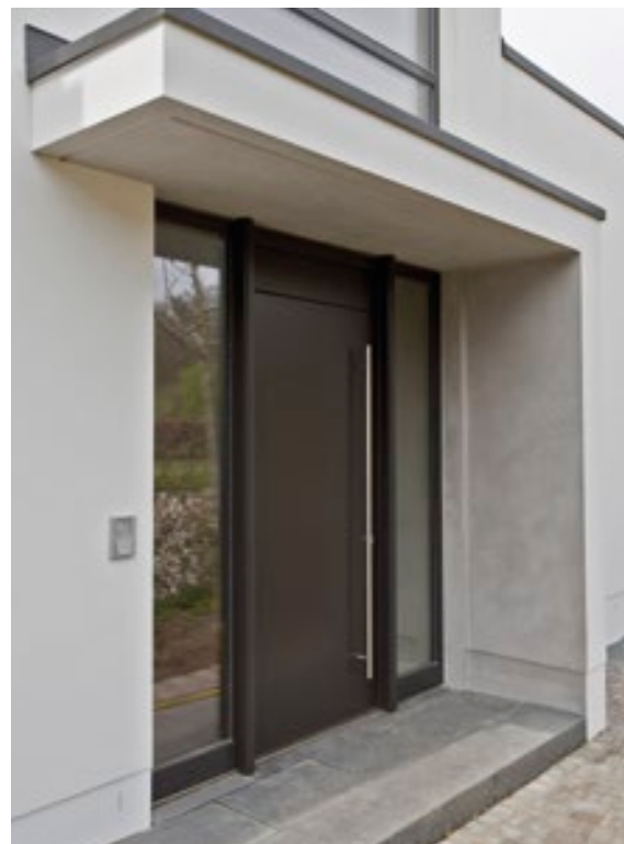
Konsequente Fortführung der Beton-Optik bis in den Außenbereich
