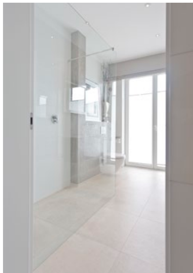
Im Gästebad wurde die frei stehende Duschwand im Gegensatz zum Hauptbad mit einer Stabstange gesichert
