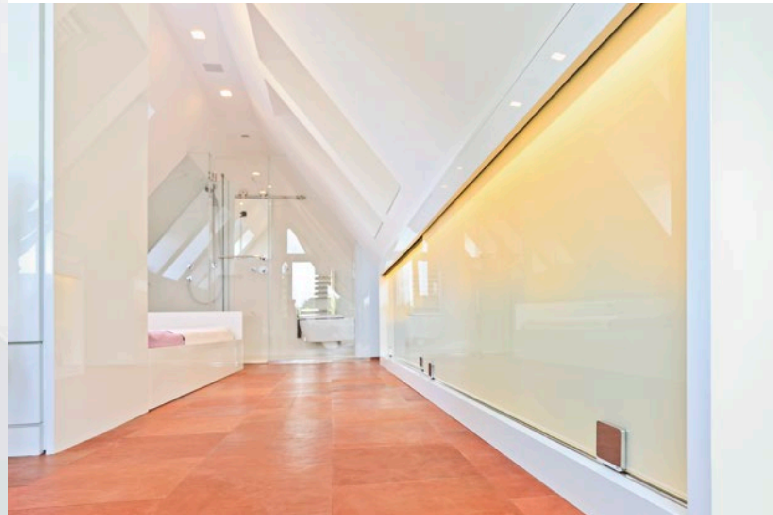
Fußboden mit Lederplatten belegt, Lieferant/Hersteller: www.kurth-manufaktur.eu
