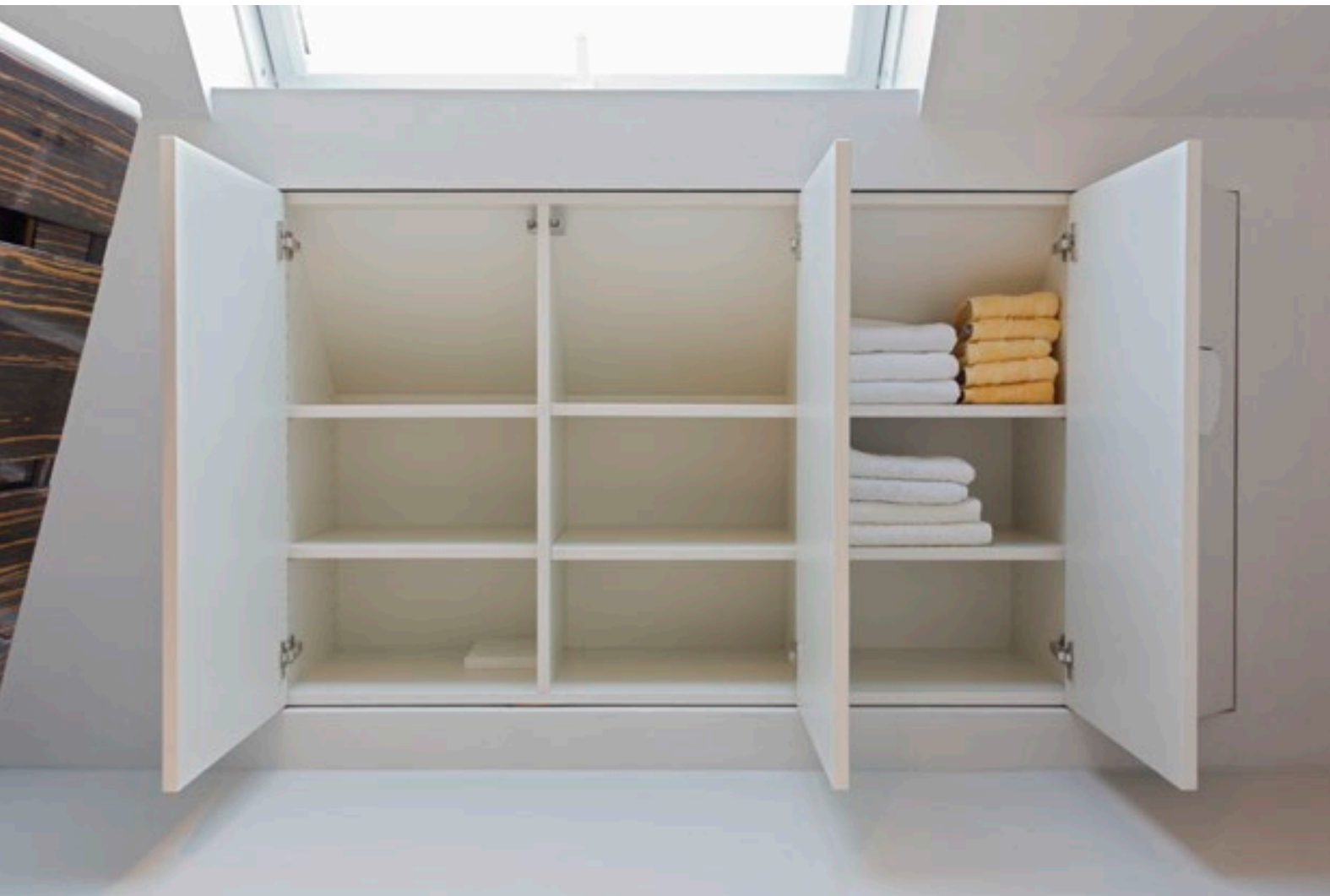
Flächenbündig eingelassener Wandschrank mit durchgehender Kalkmarmorputz-Oberfläche auf den Türelementen (Außenseiten)
