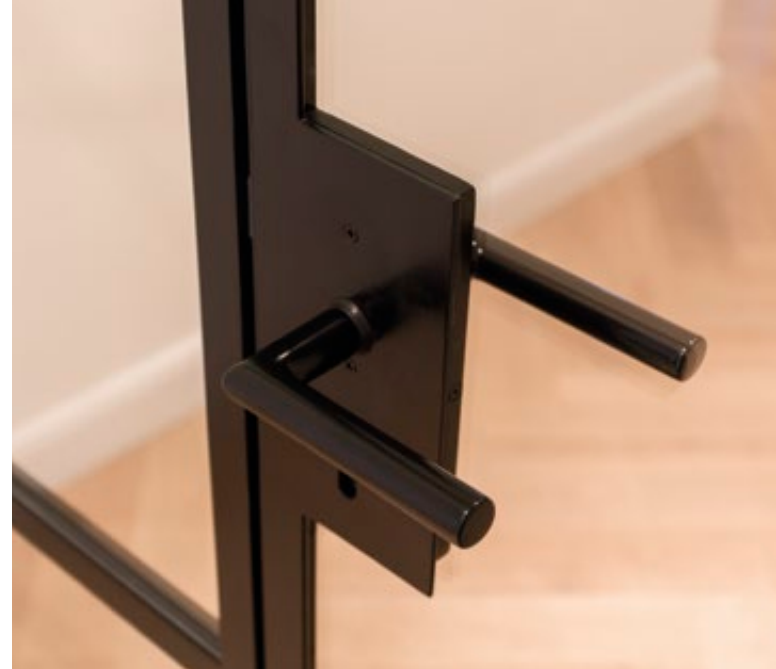
Stahlgriff: Stimmig zum Gesamtkonzept der Türenelemente wurden Schlosskasten und Drückergarnitur ebenfalls aus Stahl gefertigt
