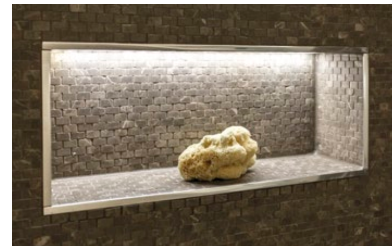
Ablagefläche in der Duschrückwand mit indirekter Beleuchtung
