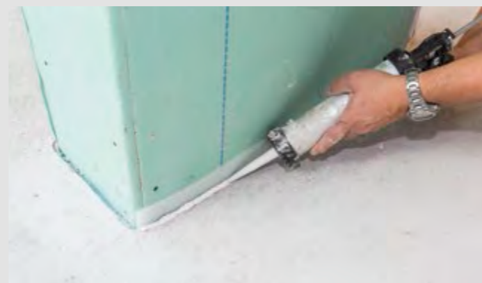
Schritt 3: Anschließend wird eine Acrylmasse aufgetragen ...
