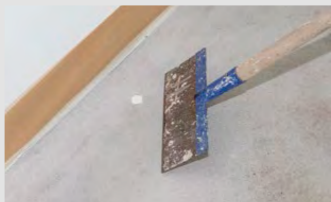
Schritt 11: Abschaben fester Verunreinigungen wie z. B. Farbreste oder Dichtmasse
