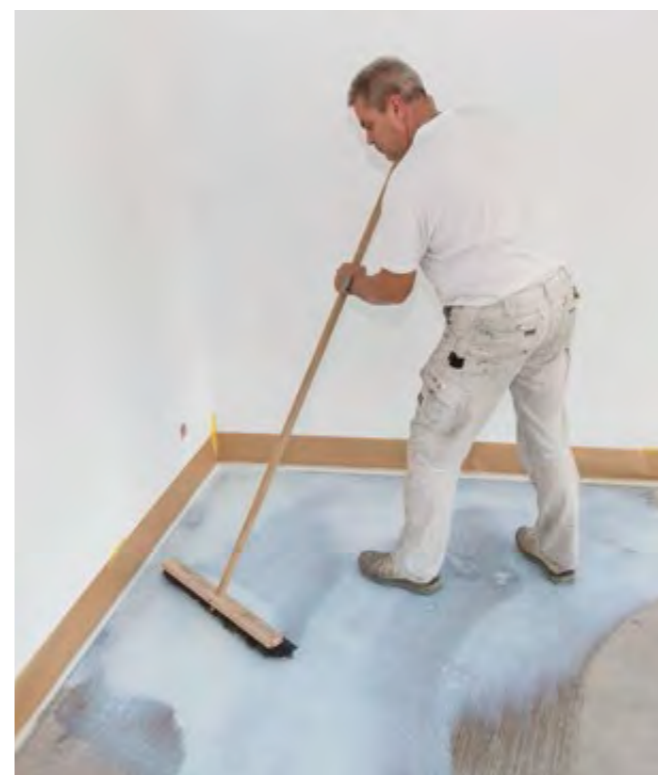
Schritt 13: Aufbringen der Grundierung
