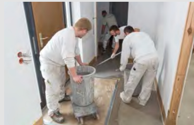
Schritt 14: Ausgießen und Verteilen des flüssigen Bodenmaterials
