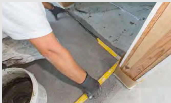
Schritt 8: Sauberes Ausrichten von Duschkanten/Abschlussleisten
