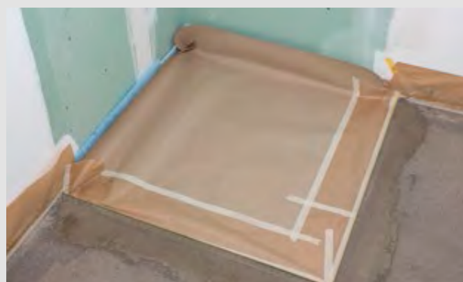
Schritt 10: Die Duschflächen müssen im Anschluss abgeklebt werden
