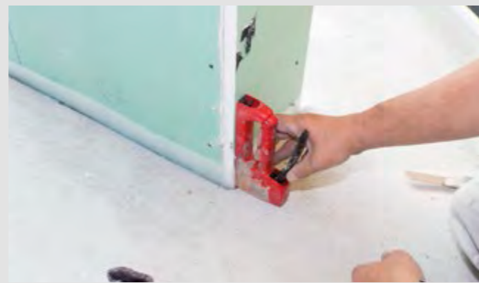
Schritt 2: ... und auf die Gipswände getackert
