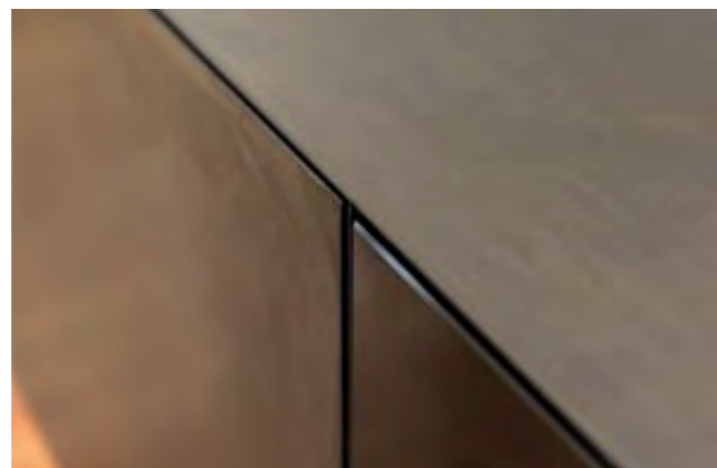
Enge Spaltmaße durch auf Gehrung geschnittene Kanten
