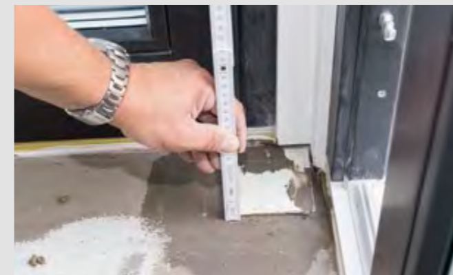
Der Gussboden trägt ca. 5 mm auf – wichtig z. B. bei der Planung bündiger Bodensteckdosen
