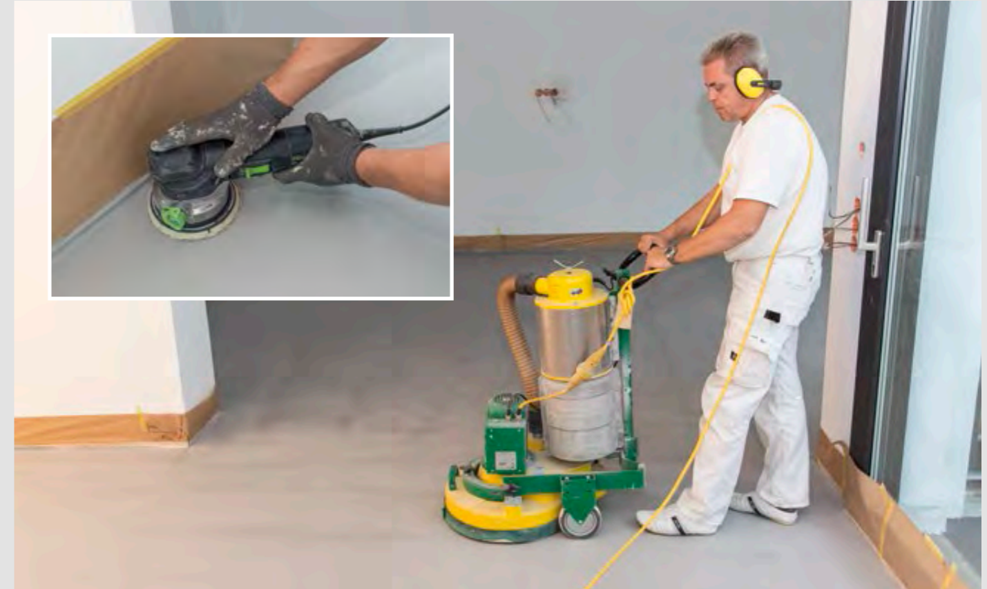
Schritt 15: am nächsten Tag können alle Flächen geschliffen und geölt werden
