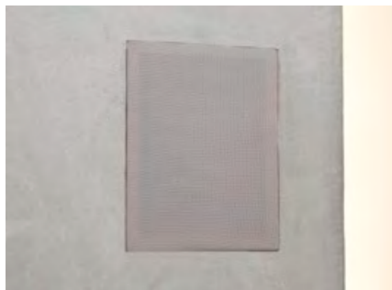
Flächenbündig eingelassene Lautsprecher-Abdeckung
