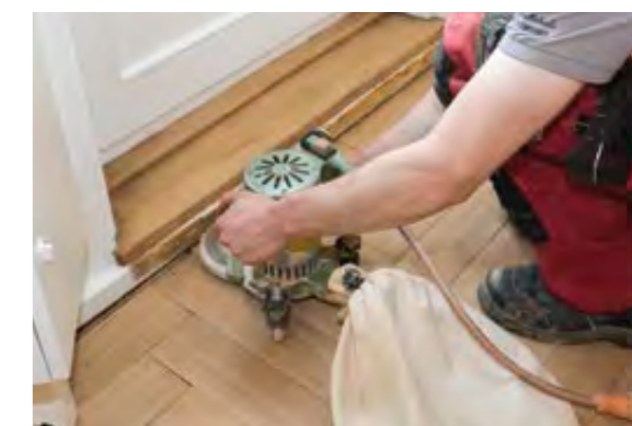
Mit speziellen Maschinen werden auch schlecht zugängliche Stellen perfekt aufgearbeitet
