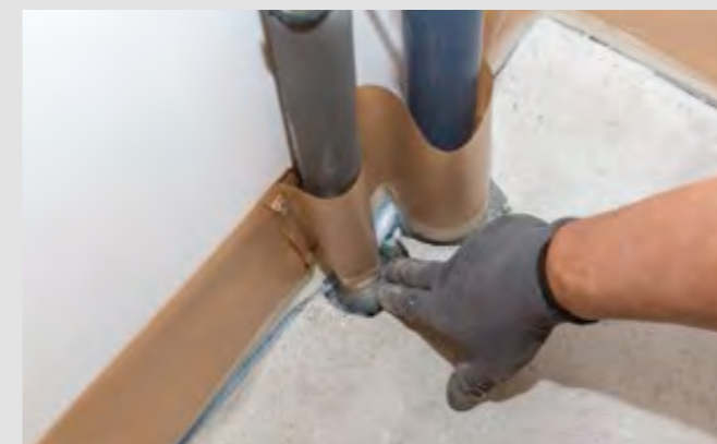
Schritt 6: Alle offenen Stellen im Estrich/Untergrund müssen geschlossen werden
