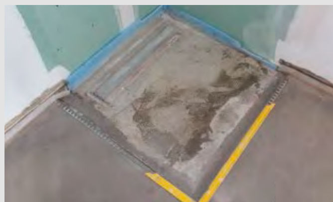
Schritt 8: Einpassen/Ausrichten einer ebenerdigen Eckdusche
