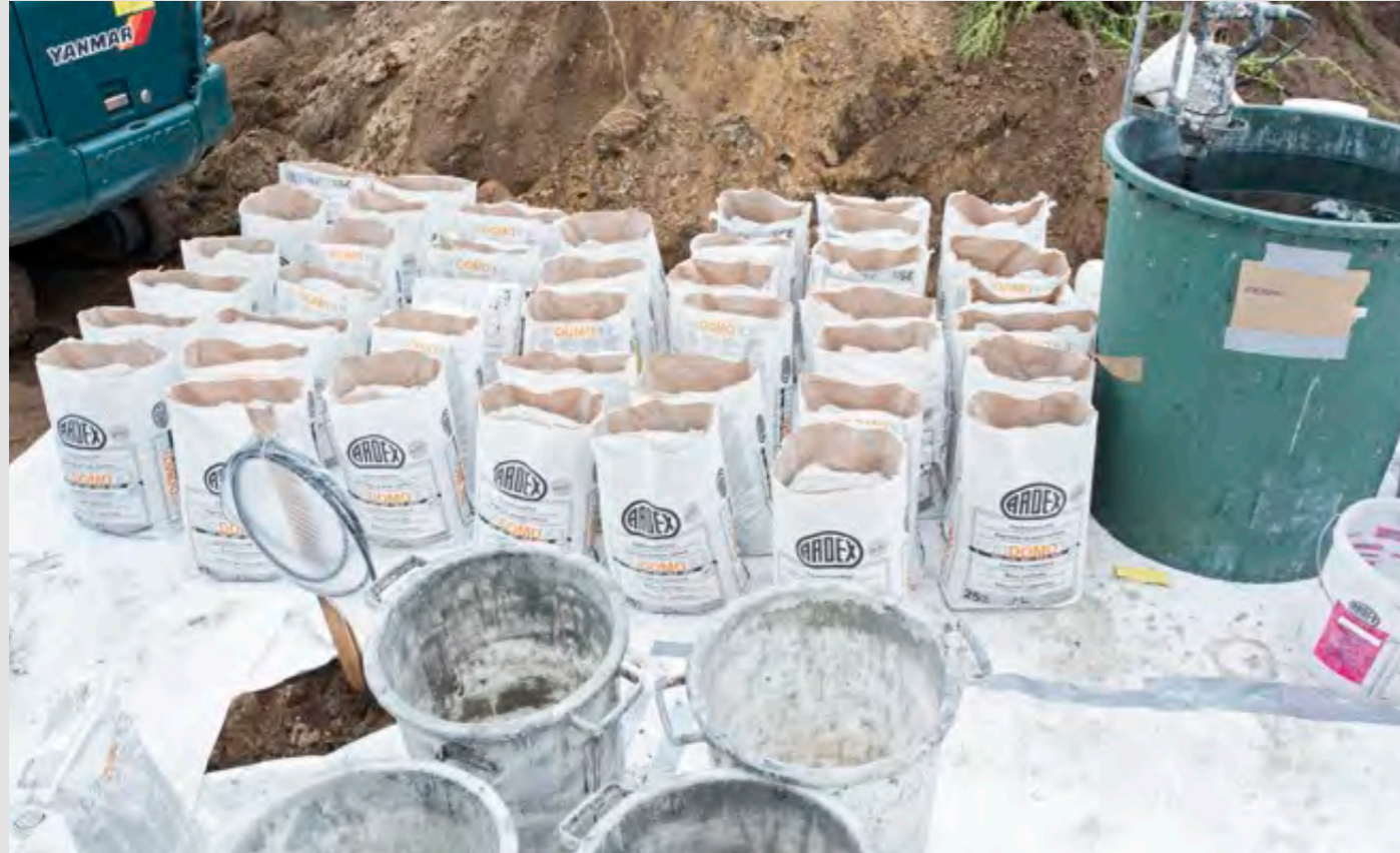
Trotz der nur 5 mm starken PANDOMO-Schicht wird für die komplette Fläche im Objekt eine Menge Material benötigt
