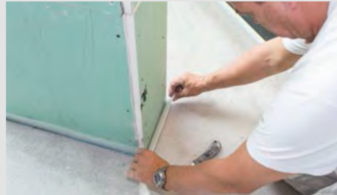
Schritt 1: Vor dem umlaufenden Versiegeln der Fläche wird ein feines Abdeckband passend gelängt ...
