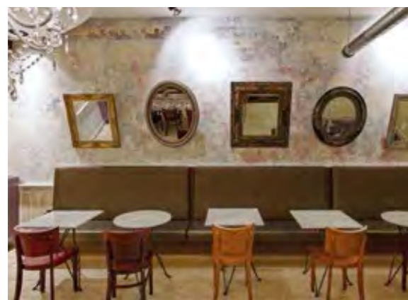
Mit Spachteltechnik umgesetzte Wandoberflächen
