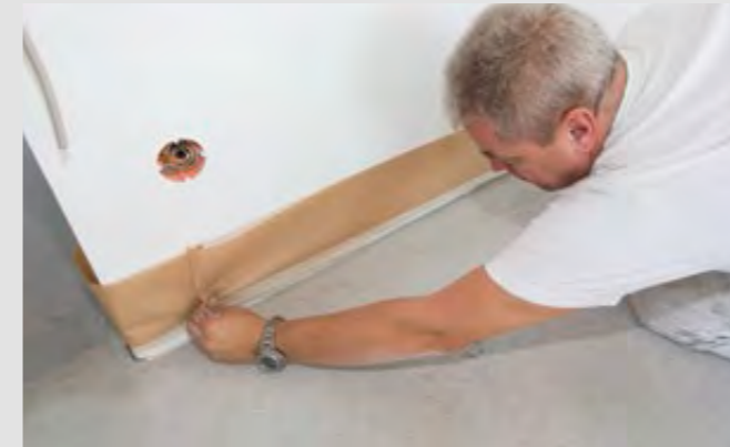
Schritt 5: Alle Kanten werden großflächig abgeklebt
