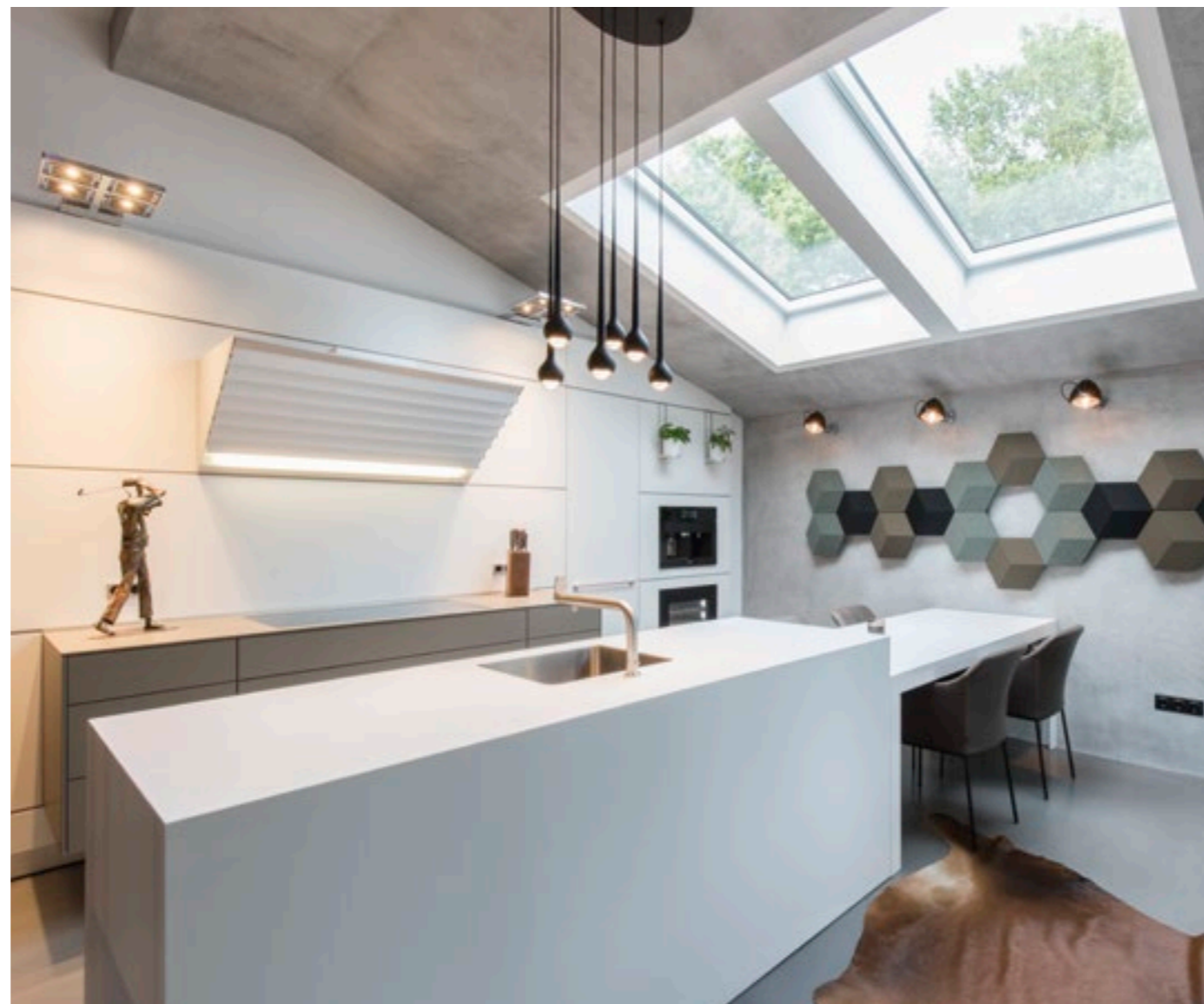
Spachteltechnik in Beton im Decken- und Wandbereich
