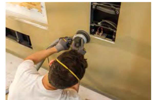
In vielen Schritten wird die Wand abgeschliffen
