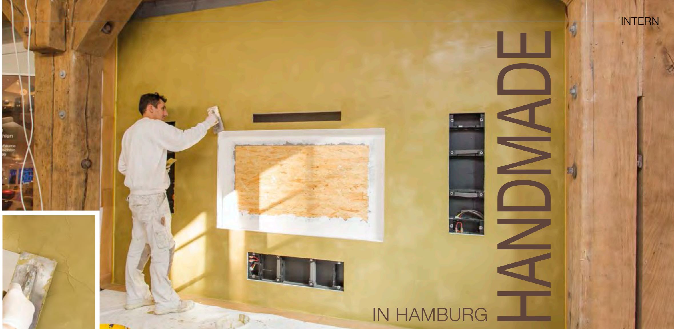
Aufbringen der Spachtelmasse mit bis zu 96 % Messing-Anteil
