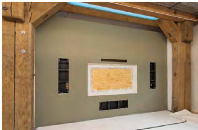
Voranstrich/Grundierung der Medienwand
