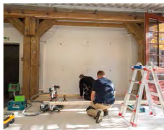
Dann wurde die Unterkonstruktion der Medienwand gebaut
