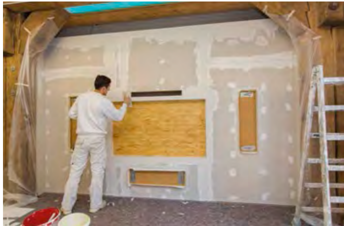
Spachteln der Fugen und Übergänge
