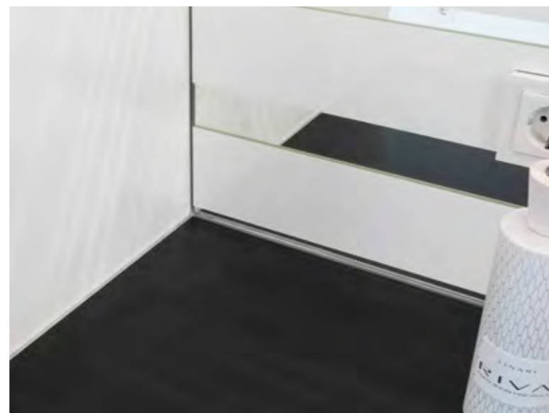
Hoher hygienischer Standard durch Glasflächen im Küchenbereich
