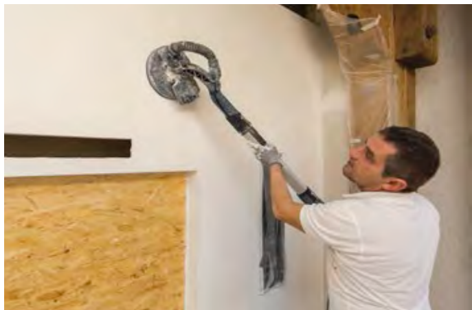
Schleifen des Untergrundes, um eine gleichmäßige Fläche zu schaffen
