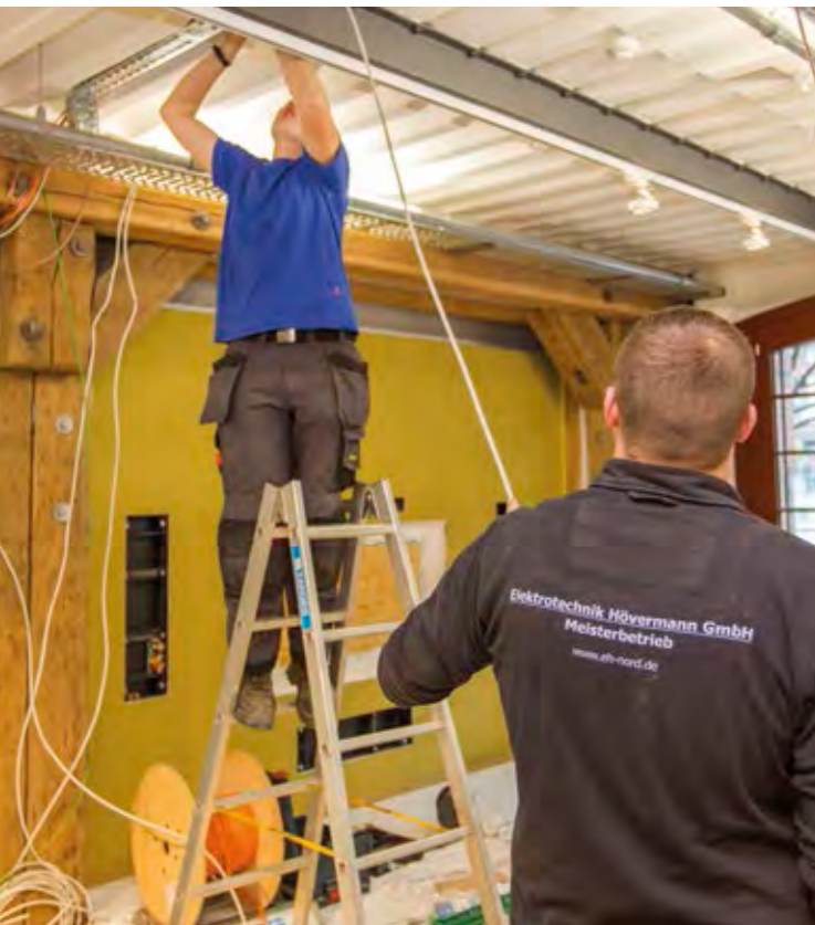
Das Team von Elektrotechnik Hövermann bei der Verkabelung
