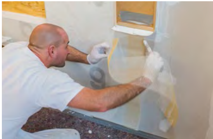
Fasermatten als Trägermaterial für die spätere Spachtelmasse
